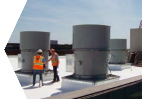
Fan Assembly Inspection
