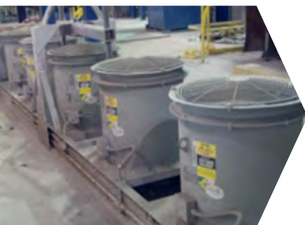
Steel Slag Cooling
